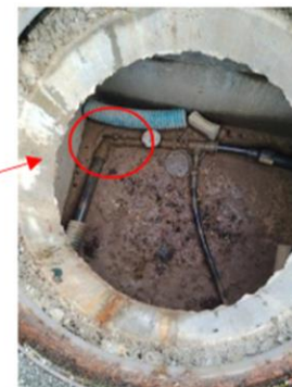
Vue de la vanne pour la coupure générale du site
