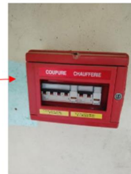
Boîtier coupure à l'extérieur - disjoncteur
