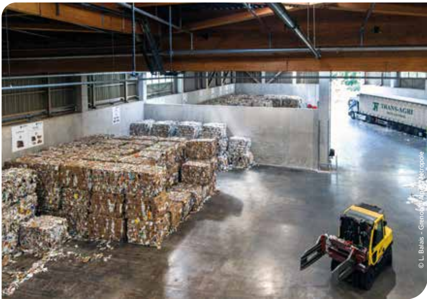
DEPUIS SA CRÉATION, LA MÉTROPOLE A DÉMONTRÉ SA CAPACITÉ À CONSTRUIRE DES PROJETS COMMUNS À GRANDE ÉCHELLE, COMME CE NOUVEAU CENTRE DE TRI, QUI A RASSEMBLÉ 7 INTERCOMMUNALITÉS REPRÉSENTANT 60 % DE LA POPULATION ISÉROISE (GRÉSIVAUDAN, PAYS VOIRONNAIS, MATHEYSINE, OISANS, TRIÈVES ET SAINT-MARCELLIN VERCORS ISÈRE).
